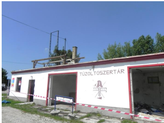
Az 1939-ben épült tűzoltószertár elbontása 2020-ban – itt épül fel majd a tornacsarnok
