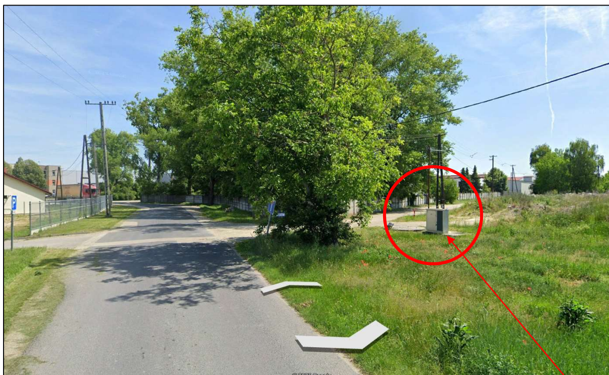
A feladatleírás 2.) pontjában szereplő 959 hrsz-ú módosítással érintett földrészleten lévő szennyvízátemelő a 960 hrsz-ú út, az Ipari út irányából /Forrás: Google Maps/
