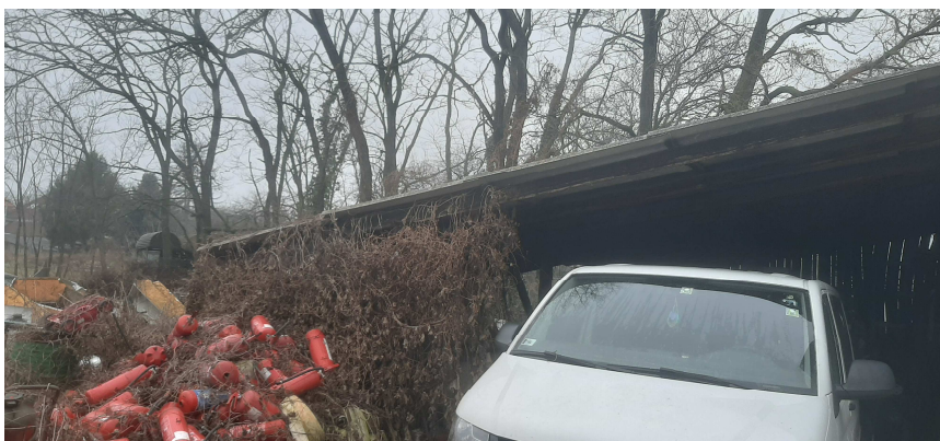
4. kép: elbontandó épületrész
