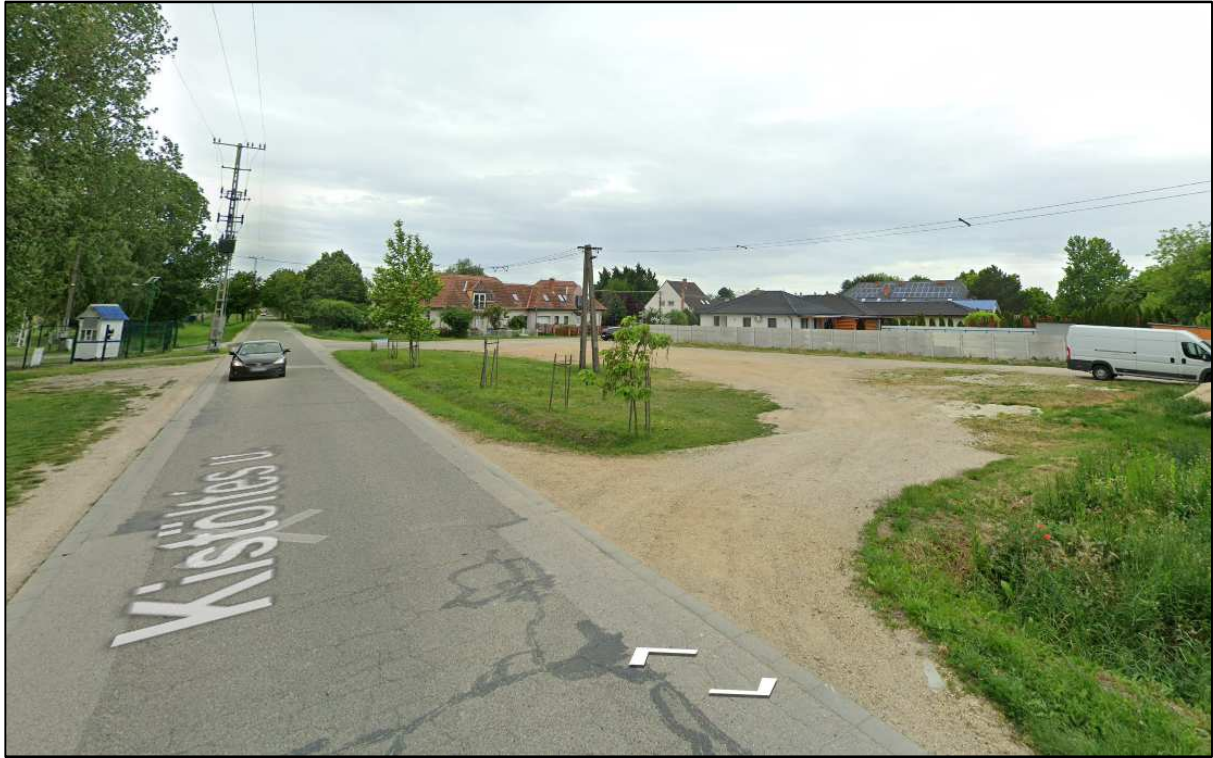
A Kistöltés utcai murvázott parkoló, a kialakult szikkasztó árokkal és közvilágítással /Forrás: KIRA Street View/
